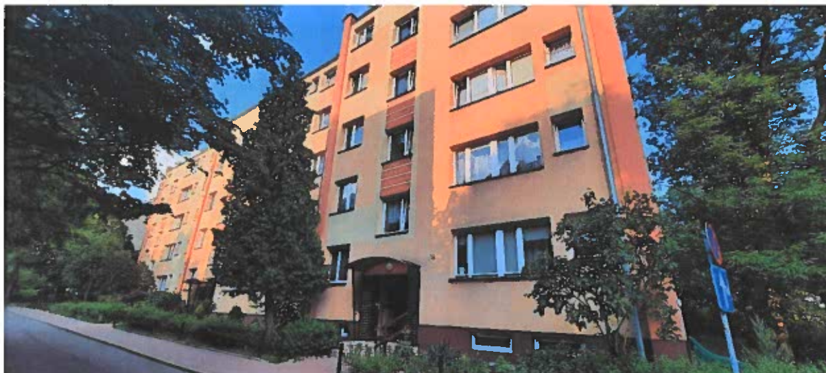
Budynek przy ul. Kubusia Puchatka 8
